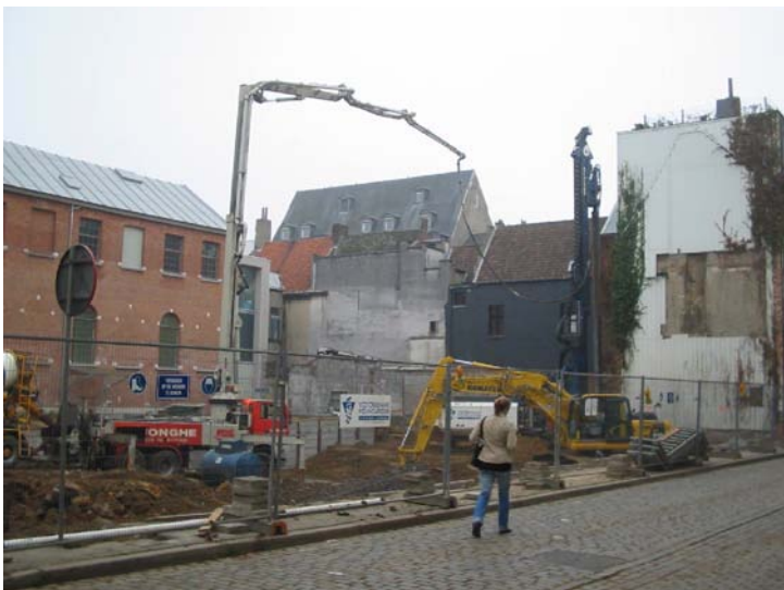
Foto: Bart'd Eyckermans - graafwerken, uitgraving bouwput eerste fase
