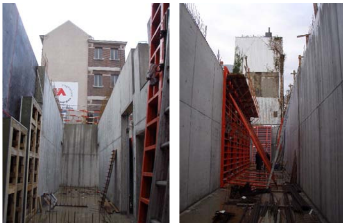
Foto's: Bart'd Eyckermans - ruwbouwwerken kelderverdieping
